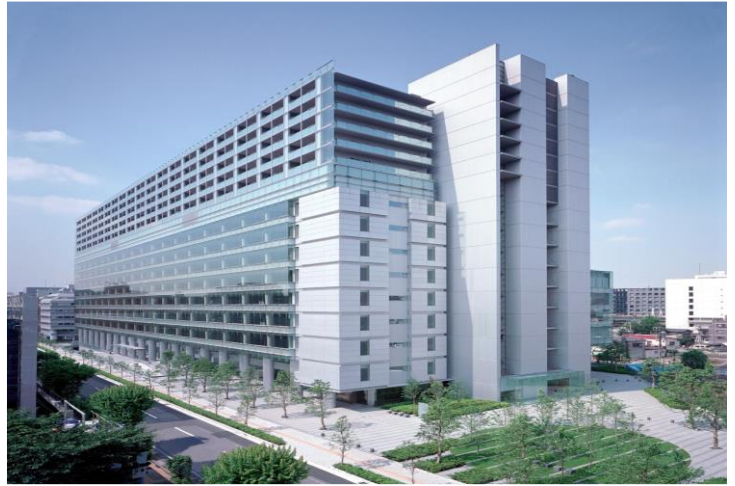
飯田橋ファーストビル
